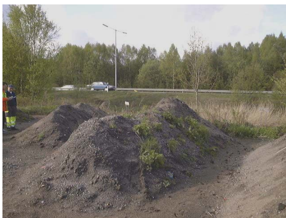
Figur 1: Uppsamlingsplatsen vid Rödbomotet där sedimentet från dagvattenbrunnarna mellanlagras.
